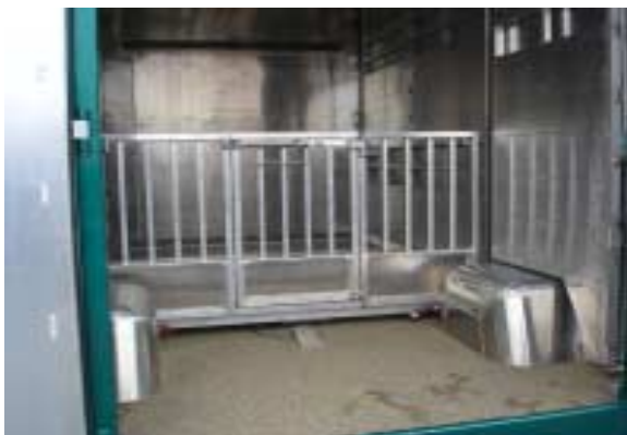
Étage hydraulique (voir aménagement spécifiques)
